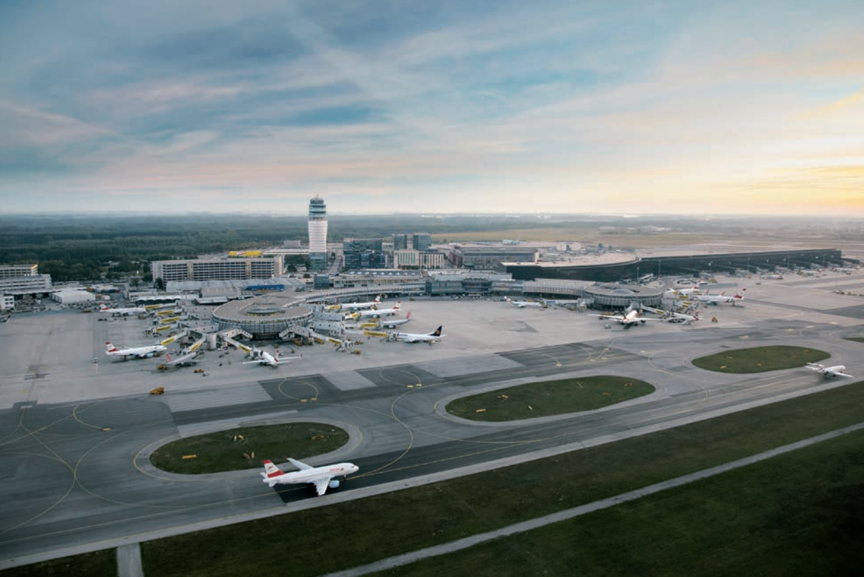
Abbildung 4: Luftansicht des Flughafen Wien
